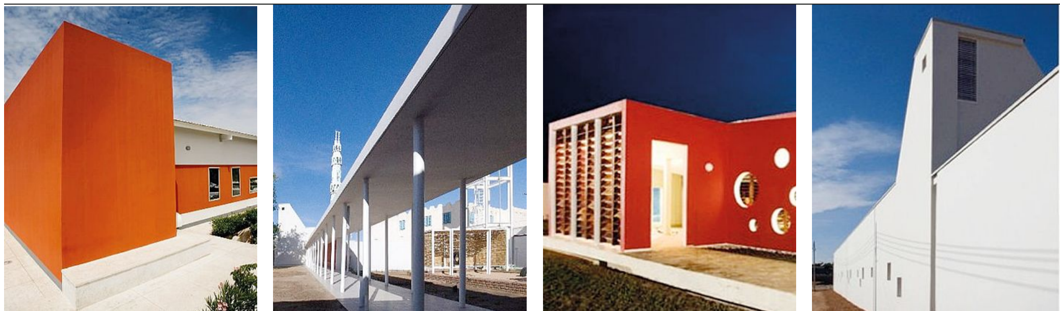
Da sinistra: il Centro di chirurgia cardiaca a Khartoum (Sudan); il Centro pediatrico di Nyala, Sud darfur (Sudan); ancora un centro pediatrico a Bangui (Repubblica centrale Africana); il corpo centrale con la torre a Nyala
